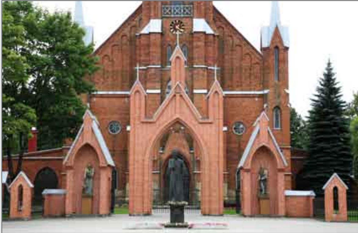
2. Naujas Katedros šventoriaus tvoros ir vartų ansamblis. Suprojektuoti 1992 m., raudonų plytų mūras, metalo strypų elementai. Projekto autorius architektas Brunonas Bakaitis.
