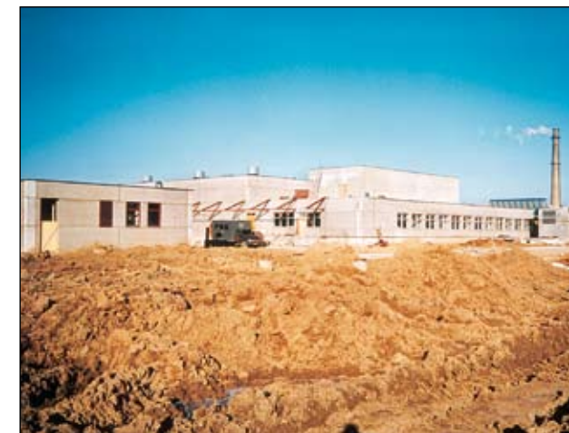
Adomo Jakšto spaustuvės statyba Kaišiadoryse, 1994 m.
