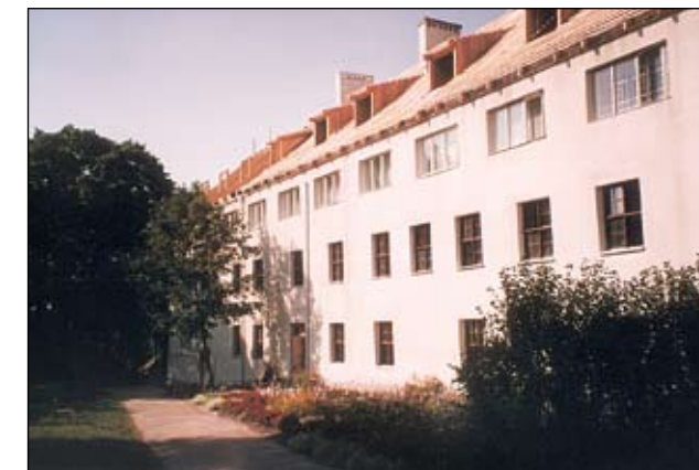
Šv. Domininko vienuolyno pastato renovacija Aukštadvaryje, 1998 m.
