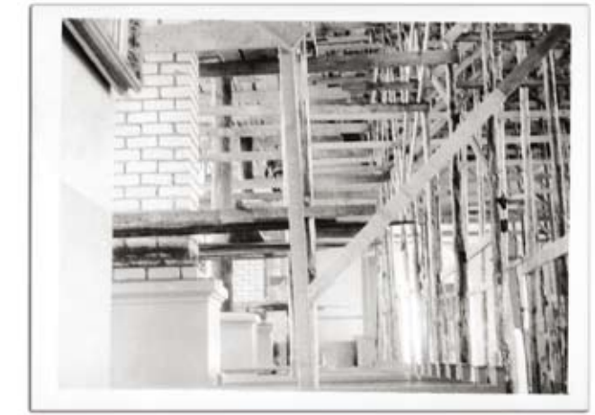
Butrimonių parapijos bažnyčios vidaus renovacija, 1977 m.
