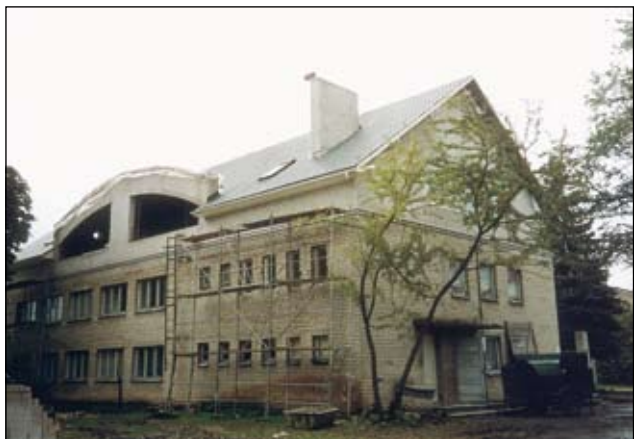
Kaišiadorių vyskupijos Sielovados centro renovacija, Kaišiadorys, 1997 m.
