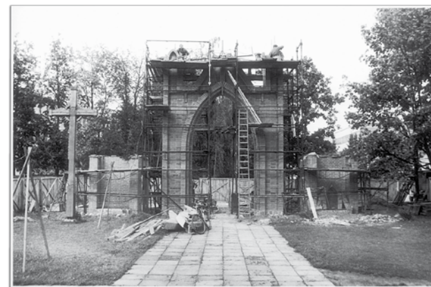
Kaišiadorių katedros šventoriaus vartų ir tvoros atstatymo darbai, 1992 m.
